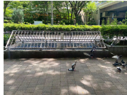
(図3) 地下鉄の排気口上の覆い
