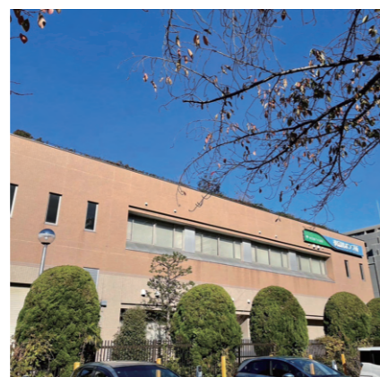
(図5) 東品川ポンプ場
